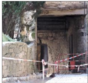
Les calades en travaux.
